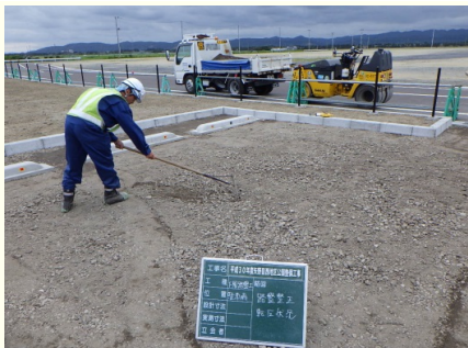
路盤整正状況(アスファルト舗装施工部)
