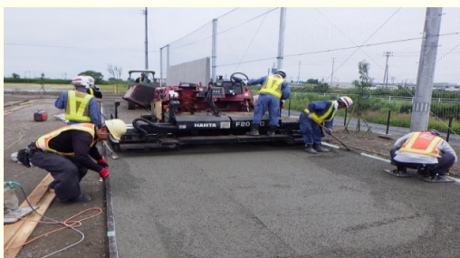
舗設状況(透水性コンクリート舗装)
