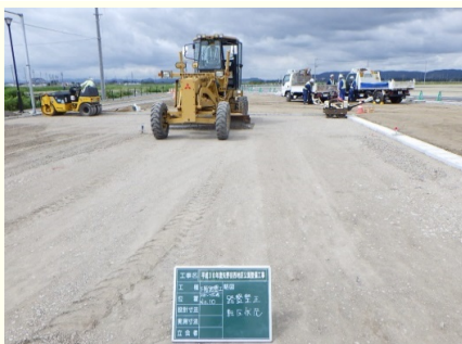
路盤整正状況(透水性コンクリート施工部)
