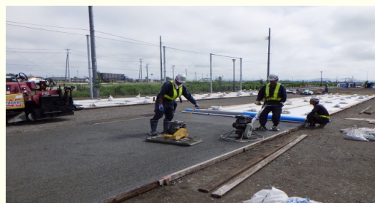
舗設状況(透水性コンクリート舗装)
