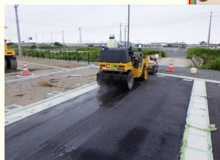
アスファルト舗装施工状況
