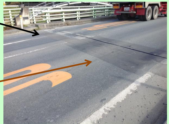
細粒合材 (施工後約2年)
