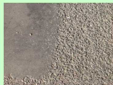
施工面 左: 施工後 右: 施工前
