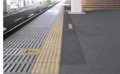
駅構内の段差修正
