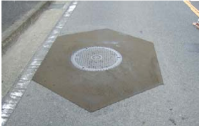
マンホール周りの段差修正
