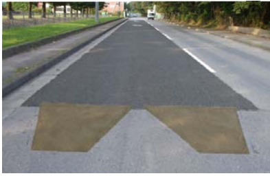
施工継ぎ目の段差修正
