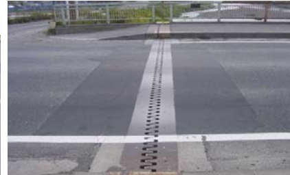
橋梁ジョイントの段差修正
