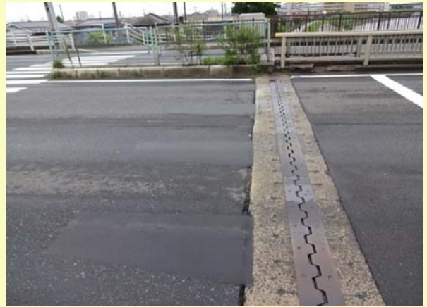
ジョイント段差修正（宮城県仙台市） 交通条件：N6交通 施工1ヶ月半後 良好
