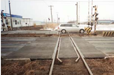
踏切内の舗装の補修
