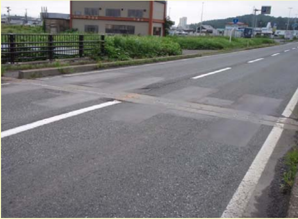
ジョイント段差修正（岩手県平泉町） 交通条件：N7交通 施工2ヶ月後 良好
