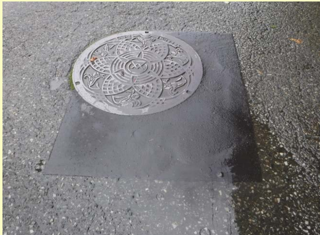
マンホール段差修正（福島県西会津町） 交通条件：N3交通以下 施工3ヶ月後 良好
