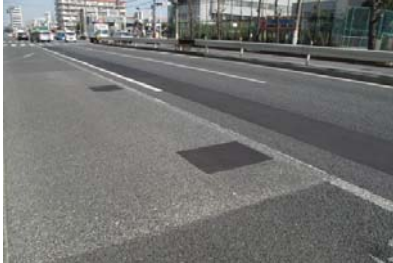
小規模補修（段差・面荒れ）
