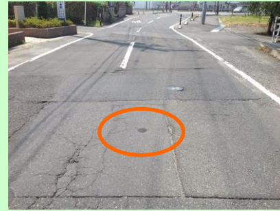
小口径ボーリング復旧後
