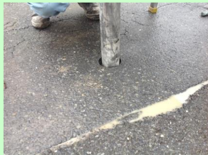
小口径ボーリング調査状況
