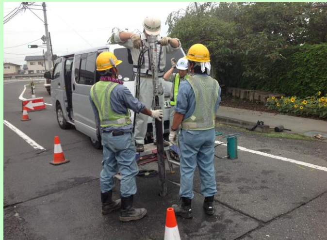
小口径ボーリング実施状況(大崎市内)
