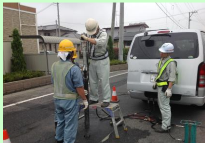
小口径ボーリングによる路盤貫入
