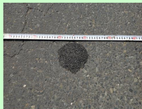
高耐久常温合材での復旧後(直径約12cm)
