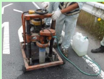
コアカッターによるアス層切
