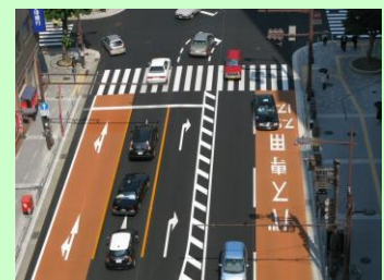
サーモテックE工法(遮熱性舗装)
