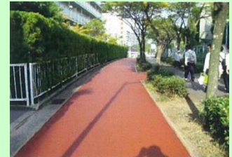
舗装面のカラー化
