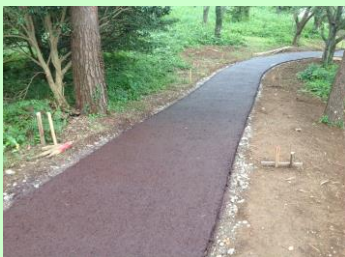
アスウッド舗装(ウッドチップ舗装)
