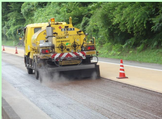
アスファルト乳剤散布状況
