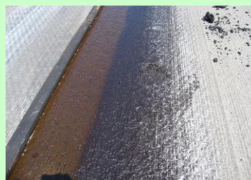
同時散布後 分解状況 右: スーパータックゾール 左: 従来品(PKM-T)
