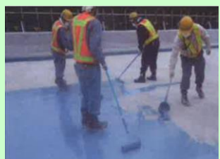
2.HQプライマーAUの塗布
