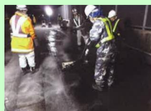
7.HQコートAUの塗布及び4号珪砂の散布
