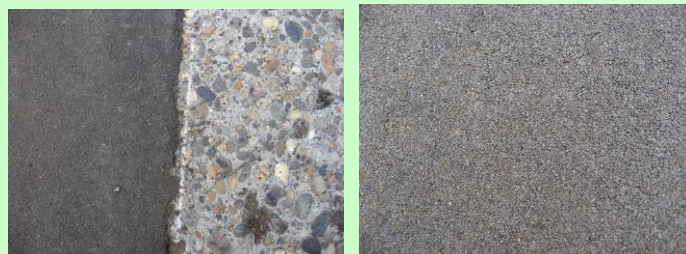
左：施工後 右：施工前
