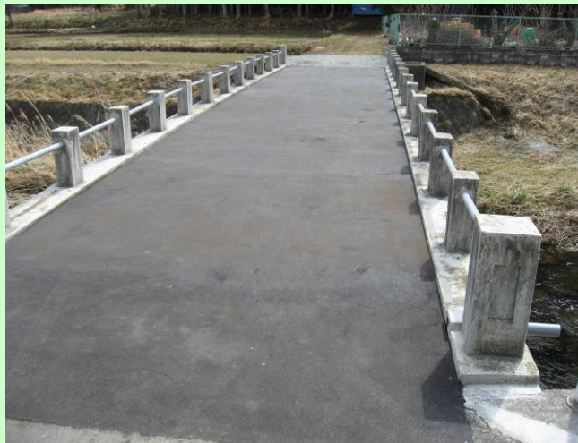
施工箇所：一関市室根町
