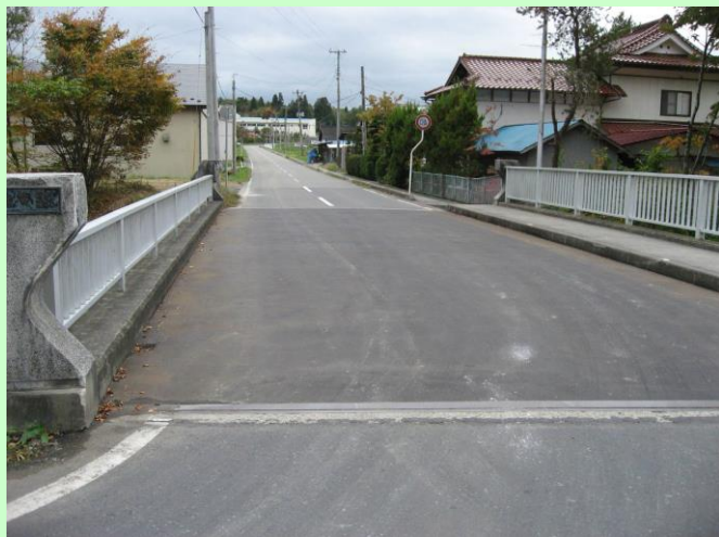
施工箇所：一関市千厩町
