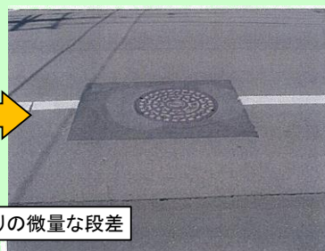
地下埋設物の影響による部分沈下クラック破損：段差 苦情対応
