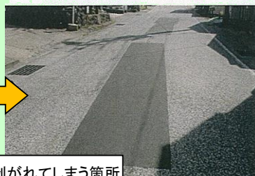
薄層での補修ではすぐに剥がれてしまう箇所
