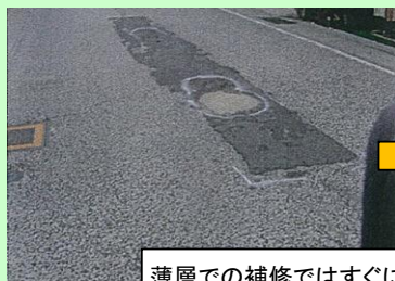
薄層での補修ではすぐに剥がれてしまう箇所
