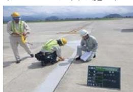
・エプロンの破損部へ、レスキューパッチSをパッチング
